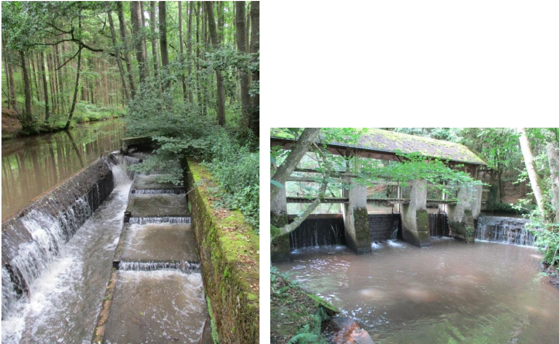
Fig. 29. Barrage de Weiler le 11/07/2017 en condition hydrologique 1.05xQMNA5
