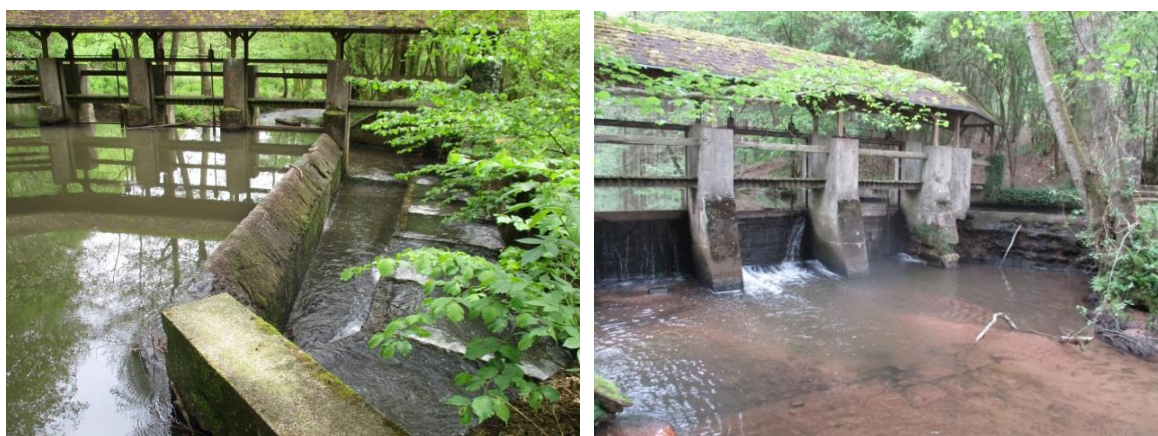
Fig. 28. Barrage de Weiler le 11/05/2017 en condition hydrologique 1.15xQMNA5
